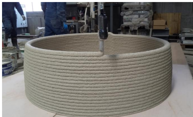
コンクリート 3D プリンターを活用した 三次元フォルムの積層造形
