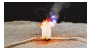
電源コード断線部から発火
