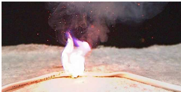
断線した電源コードの発火
