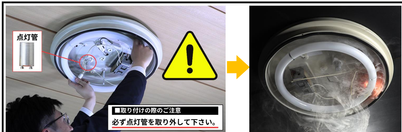
不適切なランプ交換をしている様子
