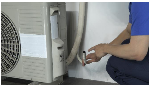
ドレンホースを確認
