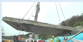
損傷した鉄筋コンクリート床版の取り外し
