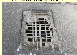
床版損傷状況※
