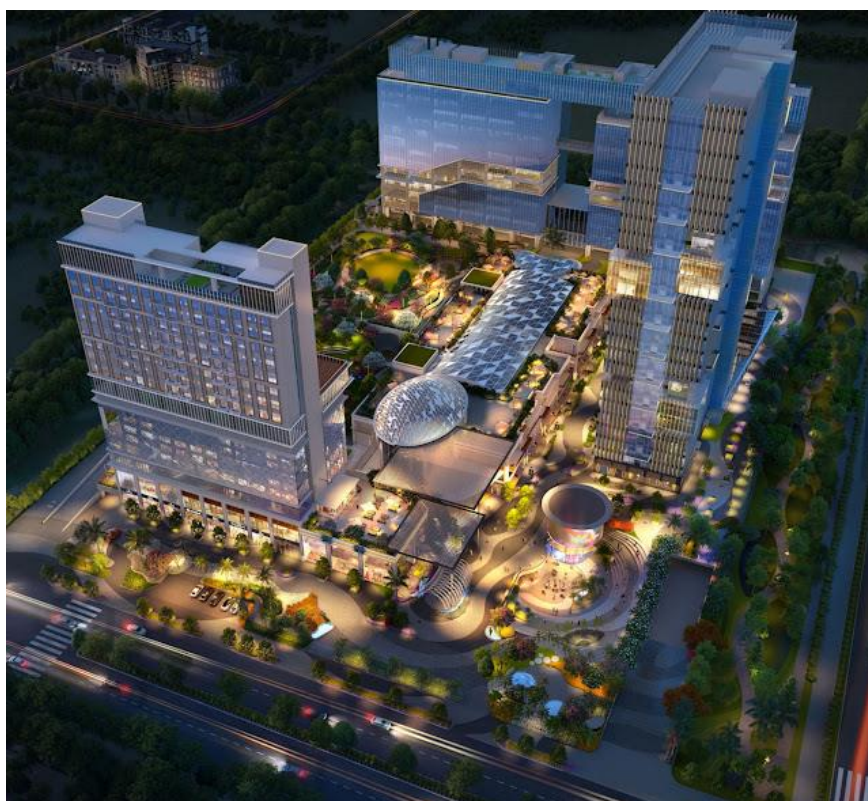
「CRC The Flagship」の外観(完成イメージ)
