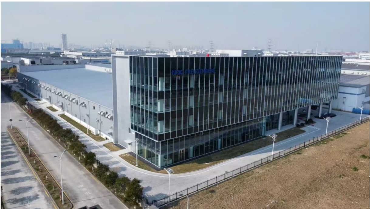
WNF 新棟 NFC 技術センター外観
