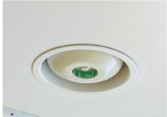
さらに、寮の厨房ではタムラテコのロングセラーである業務用オゾンガス発生装置 Space clean を設置。同機はオゾン殺菌灯と紫外線殺菌灯の両方が搭載されており、人が不在となる夜間は厨房内で高濃度オゾン燻蒸を行う一方、日中の調理作業時には低濃度オゾン放出、さらには紫外線殺菌のトリプル作用で、厨房内の衛生環境を保っています。
