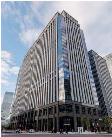
本館（呉服橋方面より撮影）
