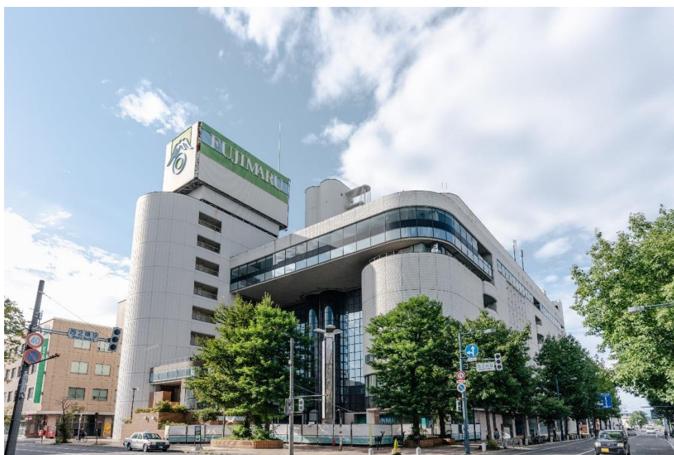
既存の藤丸百貨店を取り壊し、新設・再出発する計画
