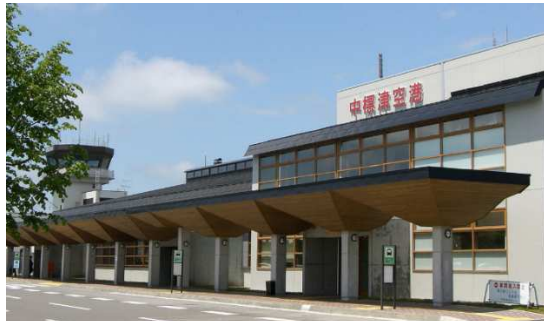
（根室中標津空港）
