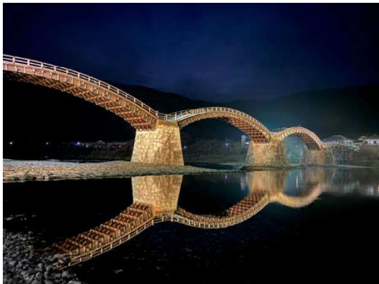
（山口県岩国市 錦帯橋）
