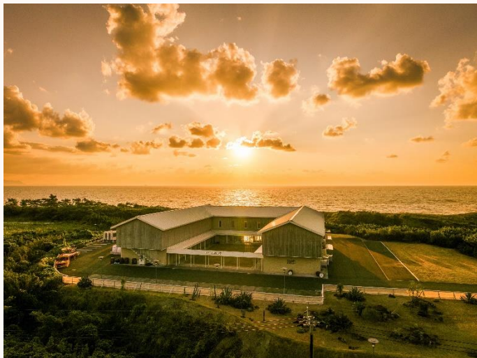
コの字型の建屋。開かれた蒸溜所を目指して建設
