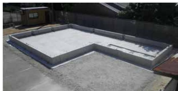
パジリス使用コンクリートPC基礎セット完了写真 (會澤高圧コンクリート株式会社製材料を使用、翠興産株式会社にてPC製作)
