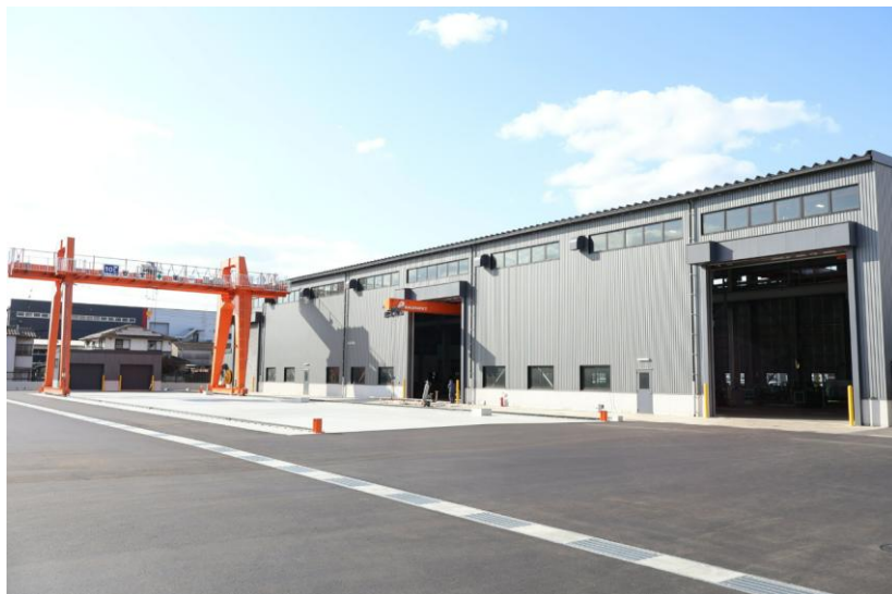
全天候型屋内工場および製品出荷場
